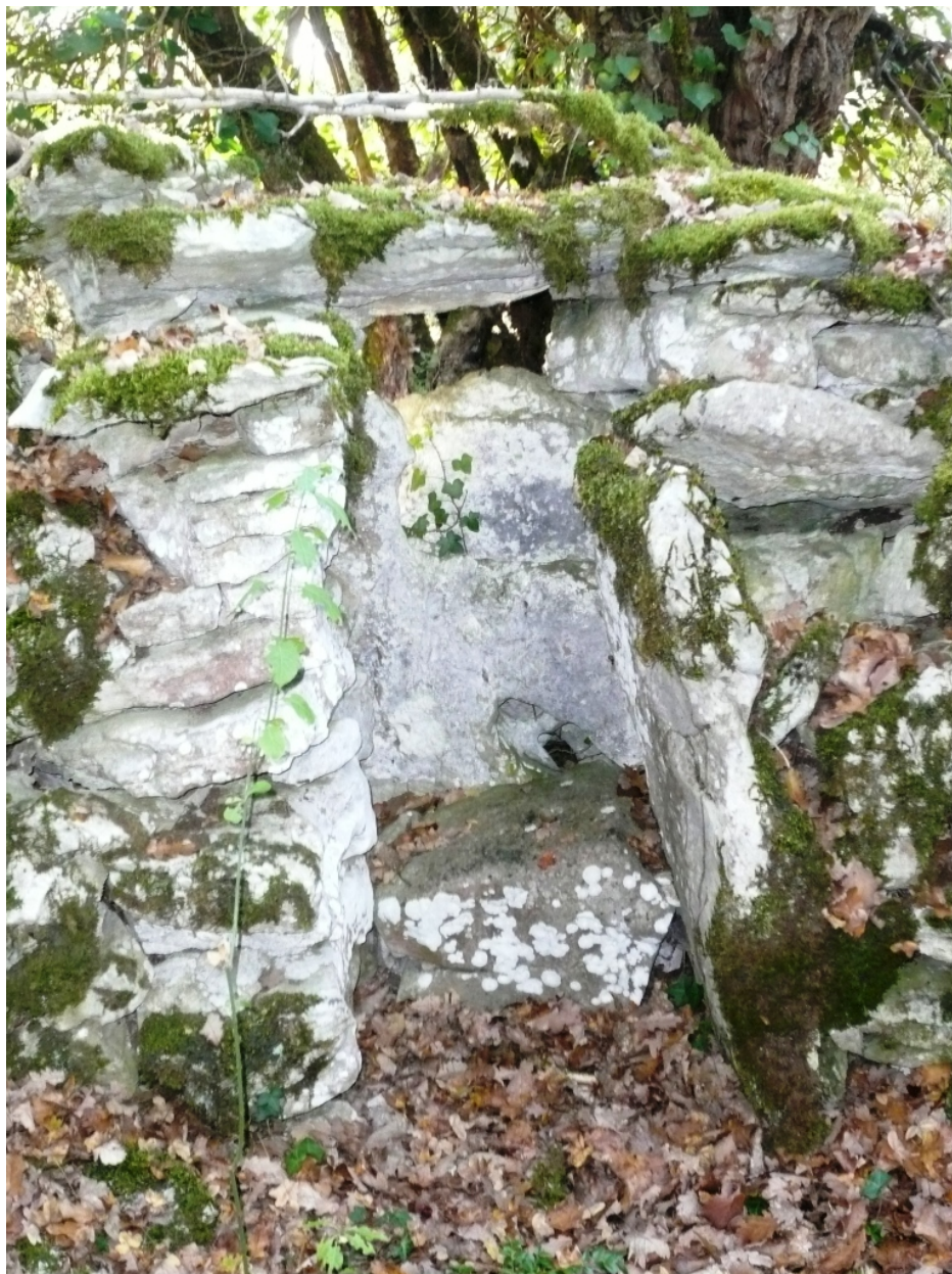
Siège dans un mur de pierres sèches
